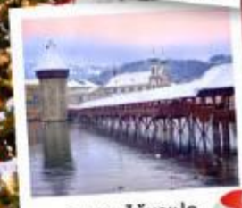
สะพานโบซาเพล
