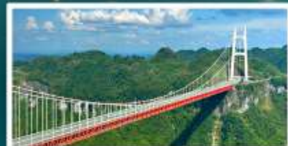
สะพานอ้ายจ้าย
